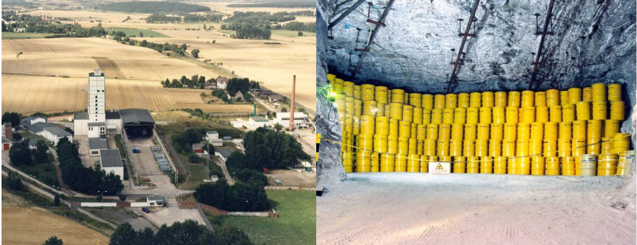
Abbildung D-10: Endlager für radioaktive Abfälle Morsleben (ERAM) (links: Luftbild, rechts: Einlagerungskammer mit gestapelten Fässern schwach radioaktiver Abfälle) (Bildrechte: BfS)
